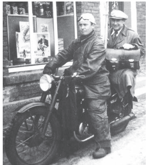
Martin Steinbrecher und Mitarbeiter auf einer „Rixe“ auf dem Weg zu einer Baustelle der Mastennachpflege
