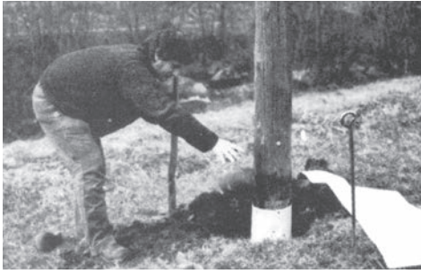
Mastennachpflege: Ein Elektroholzmast erhält eine Bandage
